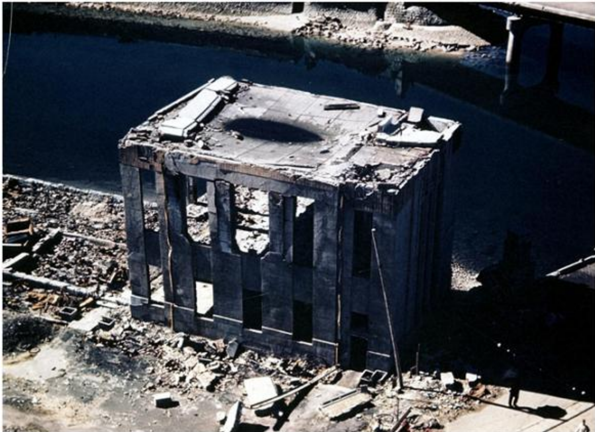
Hiroshima. L'edificio della Croce Rossa era molto vicino all'epicentro. Notare il tetto depresso a causa della esplosione avvenuta dall'alto. (Fonte: National Archives)
